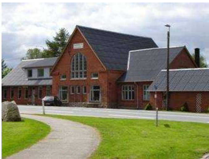
Den 4. bygning i Skjern er i dag privatejet, men var tidligere mejeri.
