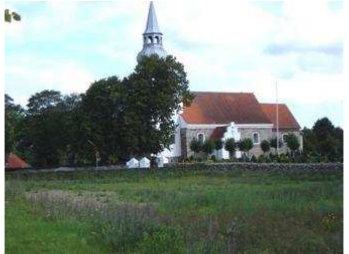
Vindum kirke set fra Vindum siden
